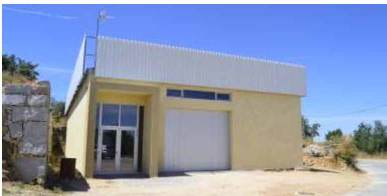
SAFURDÃO | CONSTRUÇÃO DE PAVILHÃO MULTIUSOS
