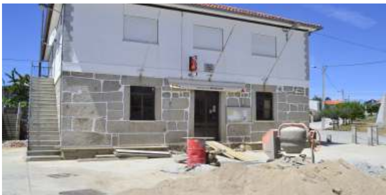
MANIGOTO | BENEFICIAÇÃO DA CASA DO POVO (INTERIOR)
