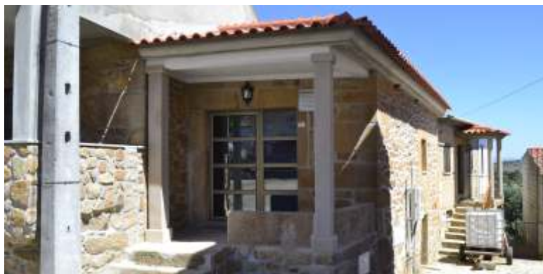
ERVEDOSA | REQUALIFICAÇÃO E ADAPTAÇÃO DE EDIFÍCIO A SEDE DE JUNTA DE FREGUESIA
