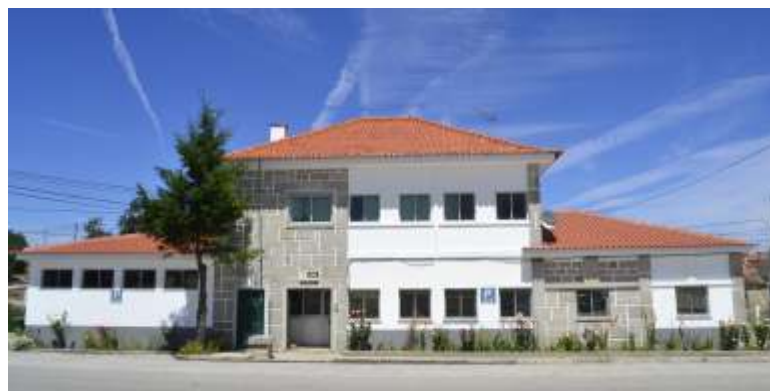
PÍNZIO | SUBSTITUIÇÃO DE TELHA E RIPADO NA COBERTURA DO POSTO DA GNR
