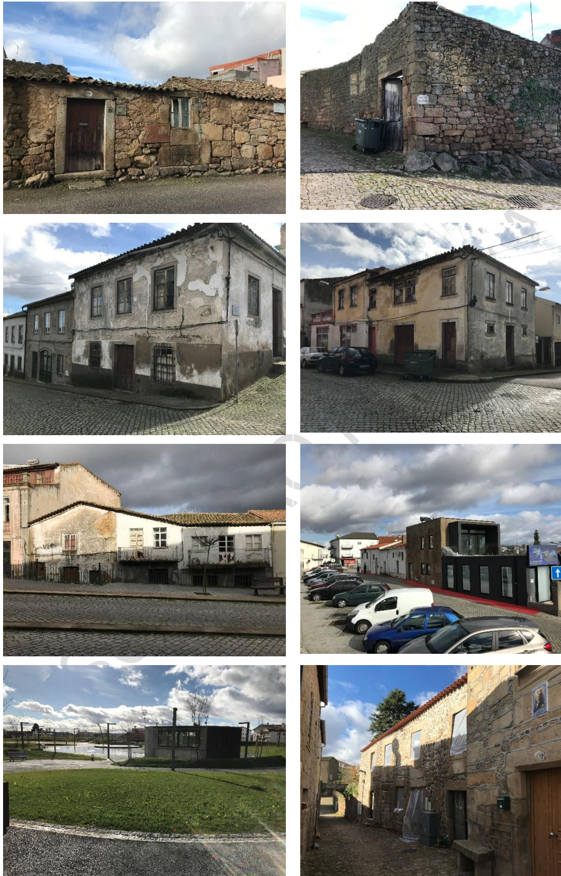
Figura 13 – Ilustração de uma amostra de edificado a necessitar de reabilitação urbana, edificado e espaço urbano reabilitado, na área da ORU (Fonte: Elaboração própria.)
